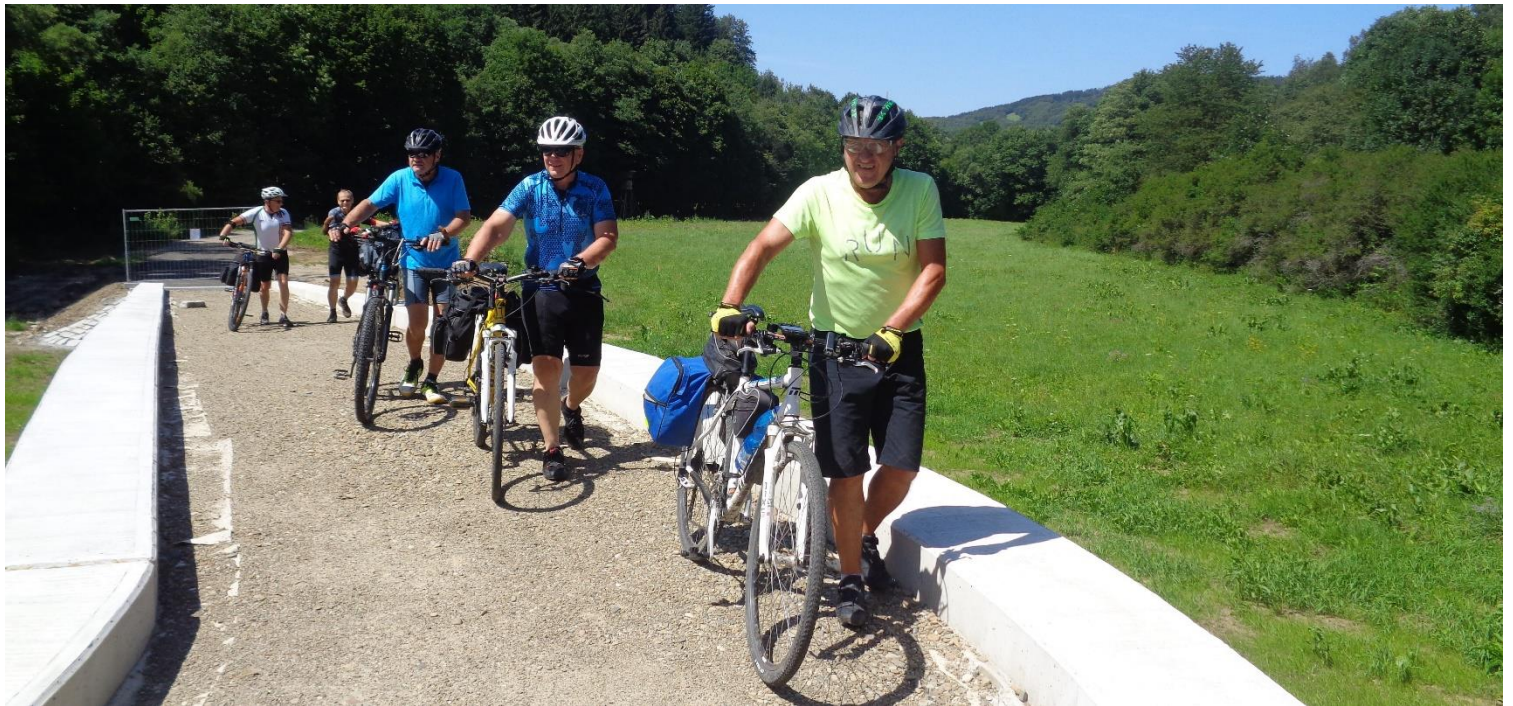
Vcházíme na most nově budované cyklostezky z Lužné do Valašských Příkaz a provádíme zatěžkávací zkoušku....
