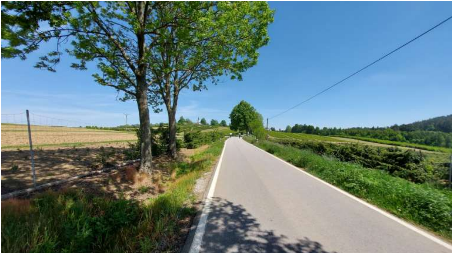
Před vesnicí Palupín s obrovskými plochami výsadeb stromků kolem silnice....
