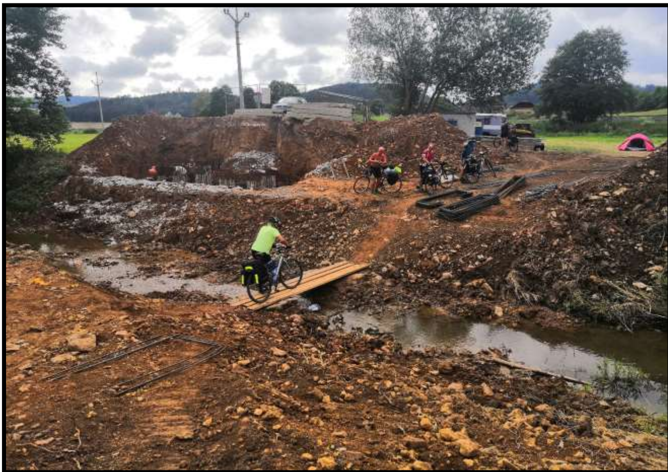
Na začátku obce Rozstání jsme využili všemožné stavební techniky k překonání říčky Třebůvka.....
